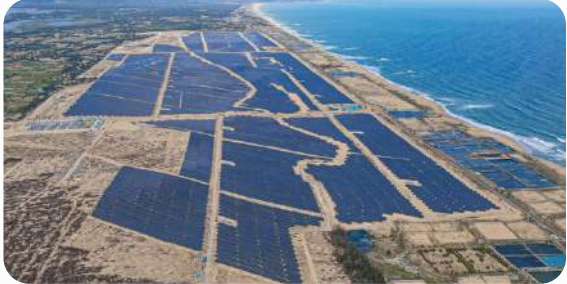
Cụm nhà máy điện mặt trời Phù Mỹ
