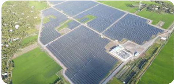
Nhà máy điện mặt trời VNECO - Vĩnh Long
