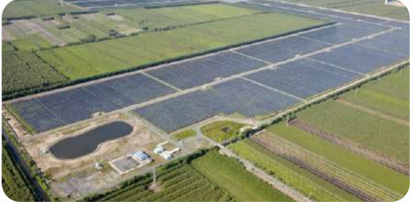
Nhà máy điện mặt trời GAIA
